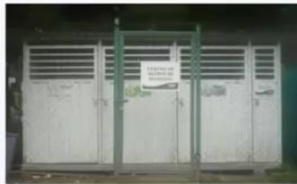
Centro de Acopio para el almacenamiento de residuos
